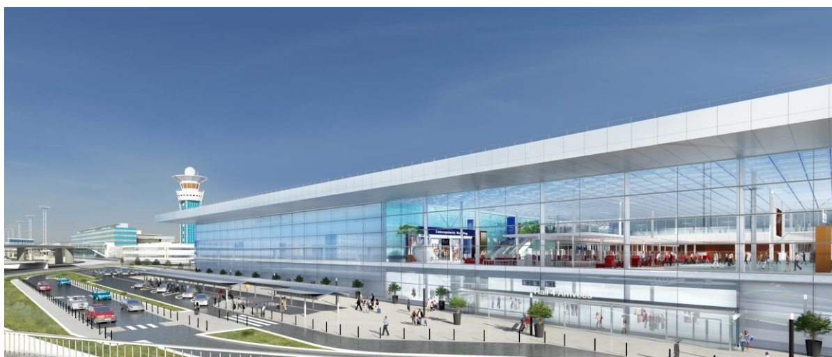
Le futur bâtiment de jonction entre les terminaux Sud et Ouest. Crédit : Aéroports de Paris
