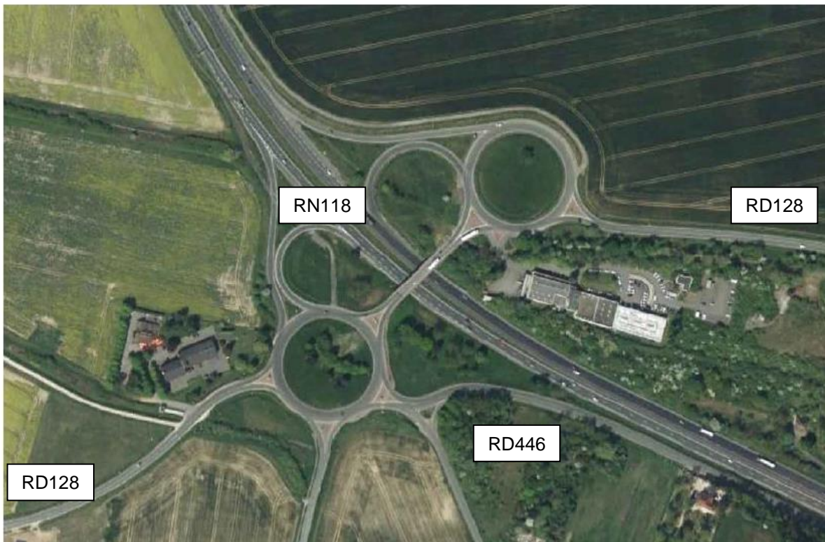
Figure 1. Vue aérienne de l'échangeur existant, EPPS, 2015
