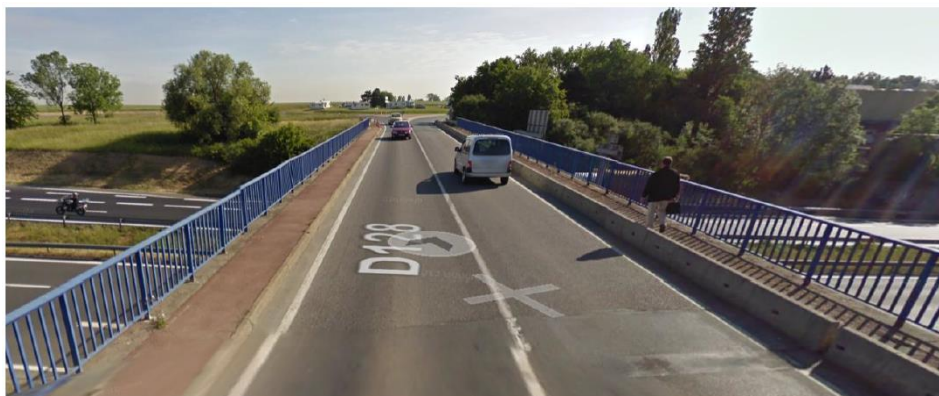
Figure 2. Pont existant sur la N118, Source Google Map
