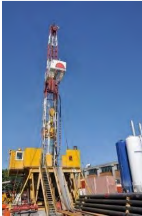
Figure 54. Rig de forage au rotary
