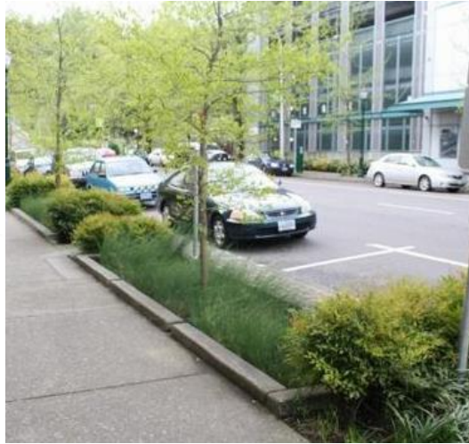
Fosses de plantation à capacité de stockage
