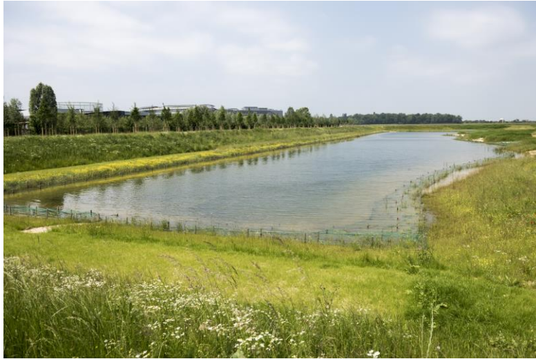
Bassin d'eaux pluviales
