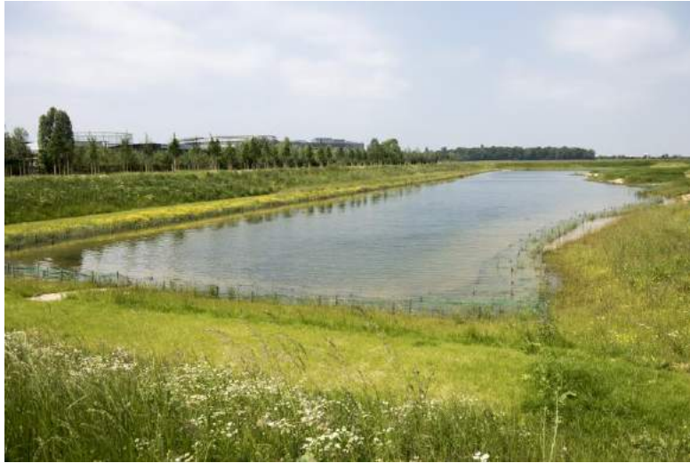
Bassin d'eaux pluviales
