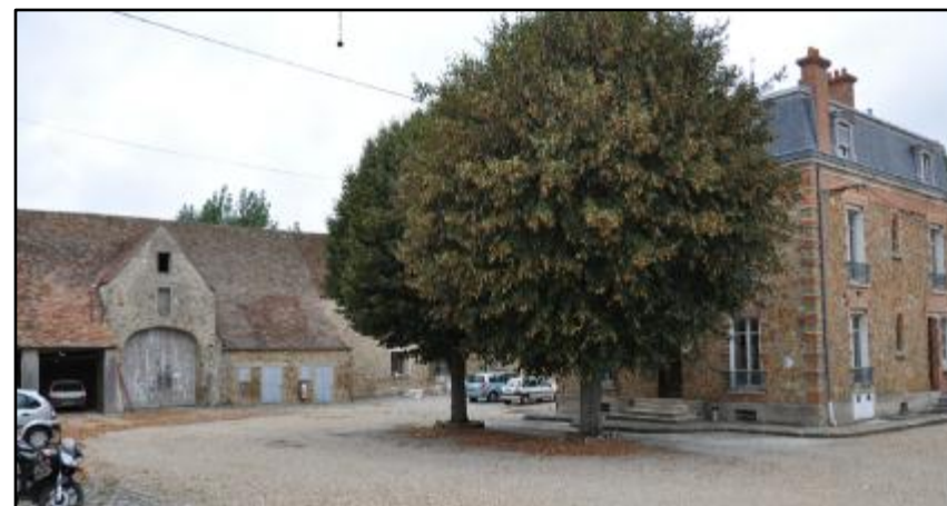
Figure 177 : Ferme de Moulon
