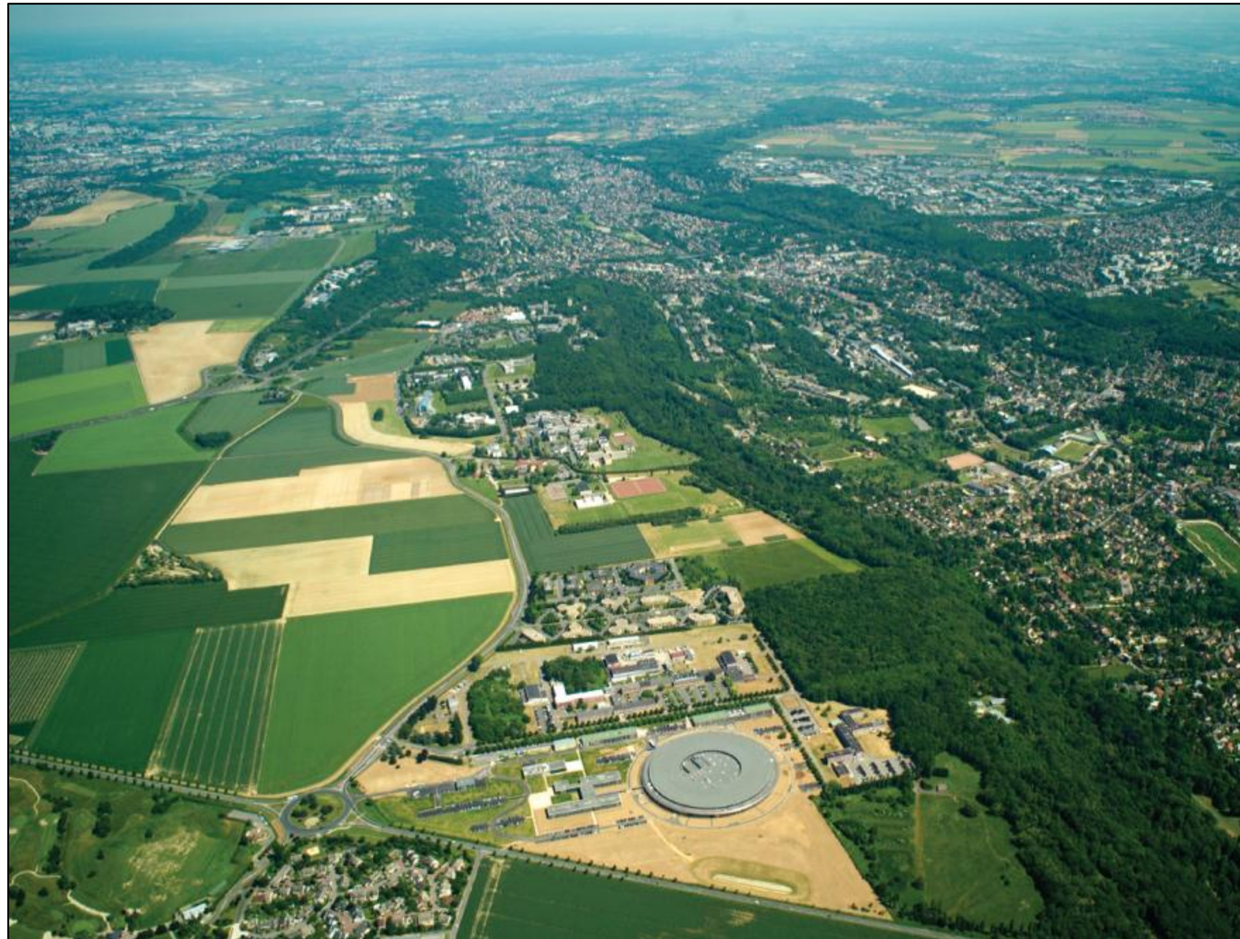
Figure 168 : Photo aérienne du terrain d'étude
