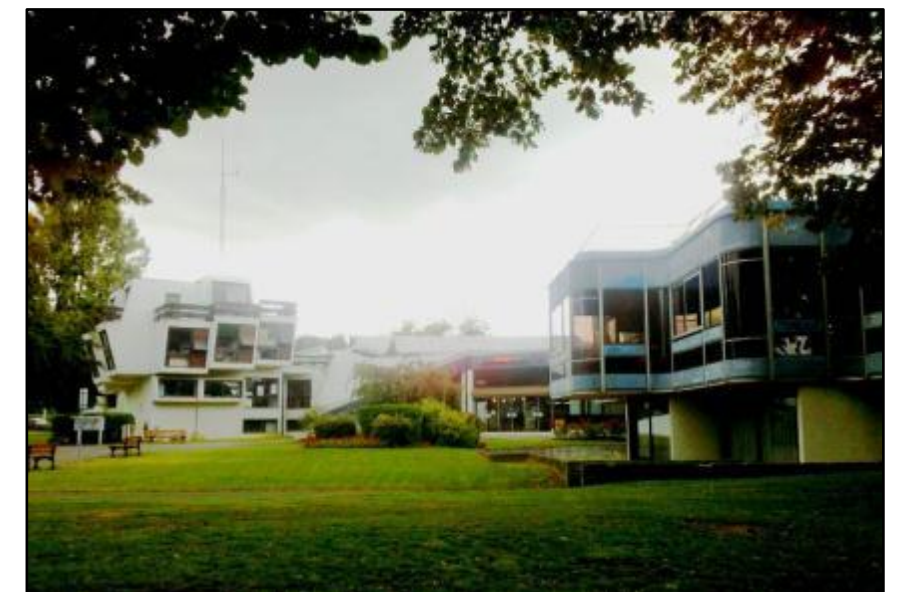
Figure 174 : Les bâtiments du CNEF
