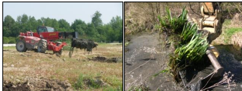
Figure 30 : Végétalisation de la mare [Ecosphère, 2012]
