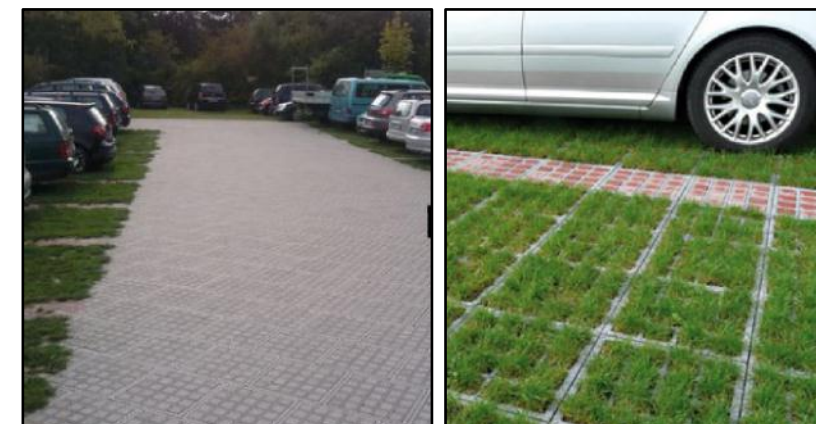
Figure 2 : Exemple de traitement perméable de surfaces d'aire de stationnement
