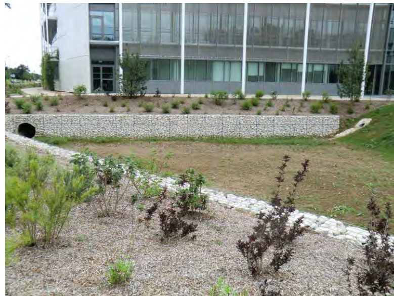
Figure 53. Ouvrages de rétention des eaux pluviales de l'ENSTA
