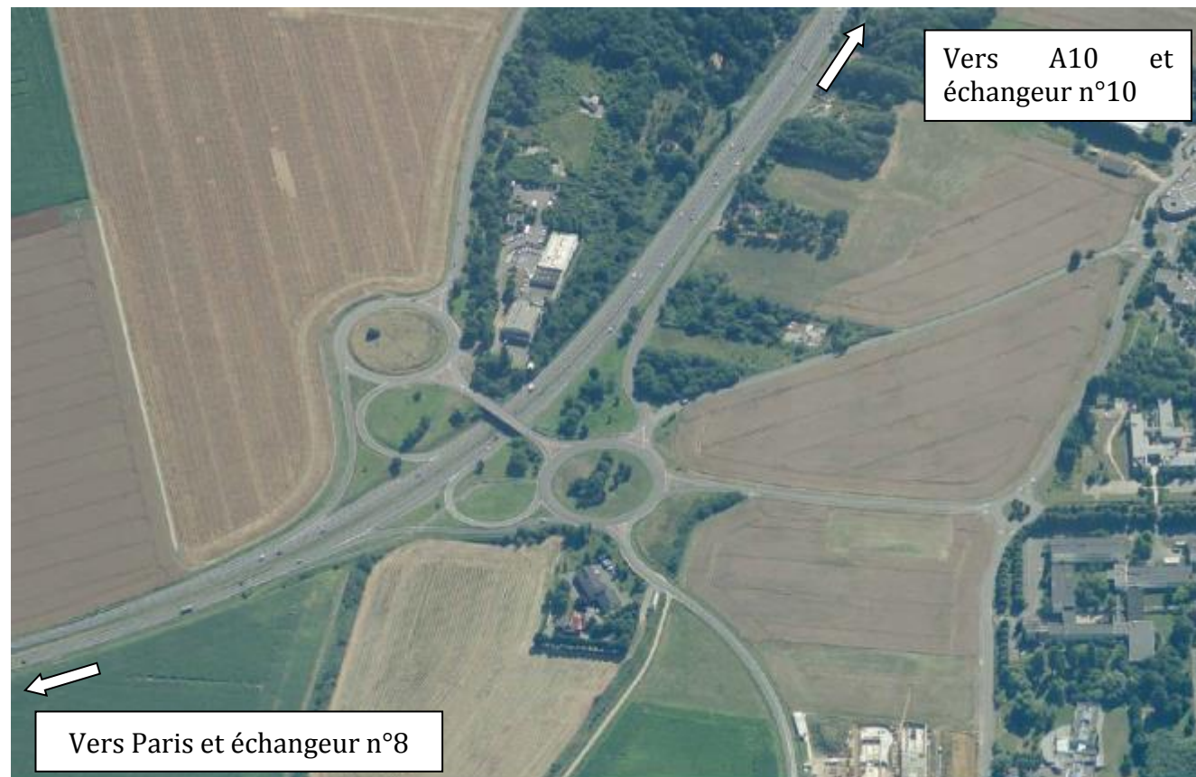
Figure 11. Vue aérienne de l'échangeur actuel.
