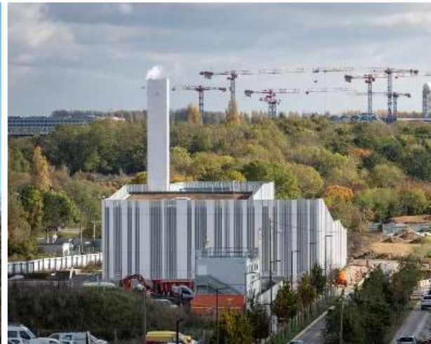
Le réseau de chaleur et de froid
