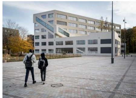
Bâtiment de la physique Livré en 2019
