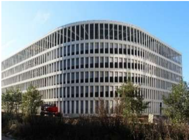
Le parking silo – livré en 2019
