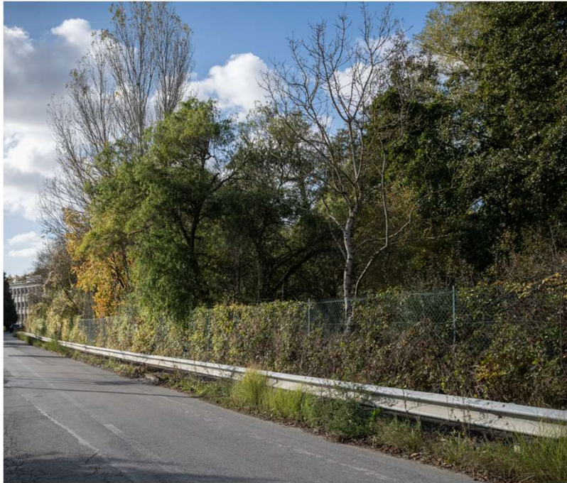
Bassin du Belvédère fermé au public
